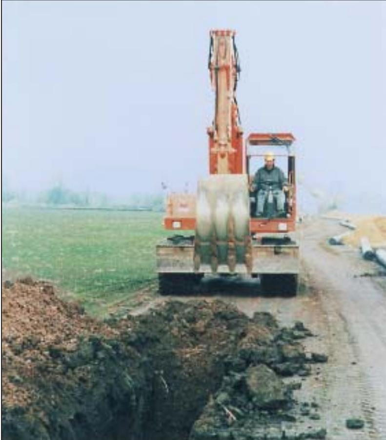
Der Rohrgraben ist fertiggestellt, wenn die vorgeschriebenen Maße für Grabentiefe und Sohlenbreite erreicht sind. Bei Annäherung an Kabel und Rohrleitungen anderer Versorgungsunternehmen ist – entsprechend den Auflagen dieser Unternehmen – Handschachtung vorzunehmen.
