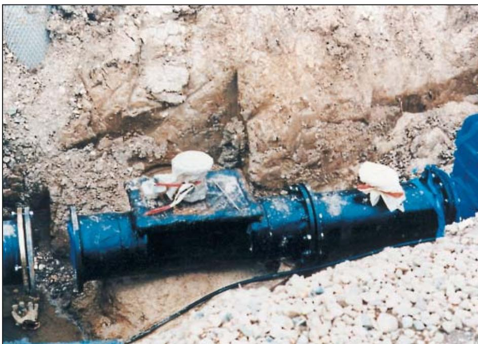
Die Nachumhüllung mit **kaltverarbeitbaren Korrosionsschutz-Systemen** nach DIN 30672 erfolgt entweder durch Einsatz von Dreischichten-Binden, die mehrfach gewickelt werden, oder durch Einsatz eines Zweibinden-Systems.
