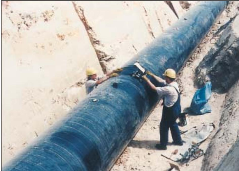
Rohrbogen und Segmentkrümmer können ebenfalls mit allen Korrosionsschutz-Systemen werkseitig oder auf der Baustelle umhüllt bzw. nachumhüllt werden.
