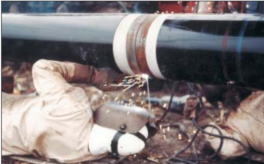
Analog erfolgt das Schweißen der Stumpfschweißverbindungen an befahrbaren Stahlleitungsrohren. Hierbei erfolgt das Schweißen der Fall- oder Steigenähte in der Regel durch 2 Schweißer (Bild 8.18).
