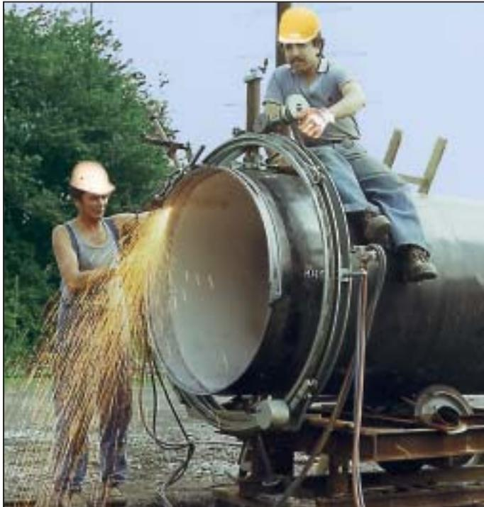
Nach dem Trennen des Rohres wird die Schweißfuge angeschliffen (Anschrägwinkel der Fugenflanke  $30^\circ +5^\circ_0$ -Steghöhe  $1,6 \pm 0,8$  mm) und das Rohrende außen vorzugsweise mit einer maschinellen Topfbürste auf einer Breite von ca. 50 mm (bis DN 500) bzw. 100 mm (ab DN 500) gesäubert.
