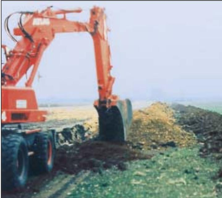
Nach Herstellung des Auflagers schwenkt später ein weiterer Bagger die zuvor ausgelegten Rohre in den Rohrgraben.
