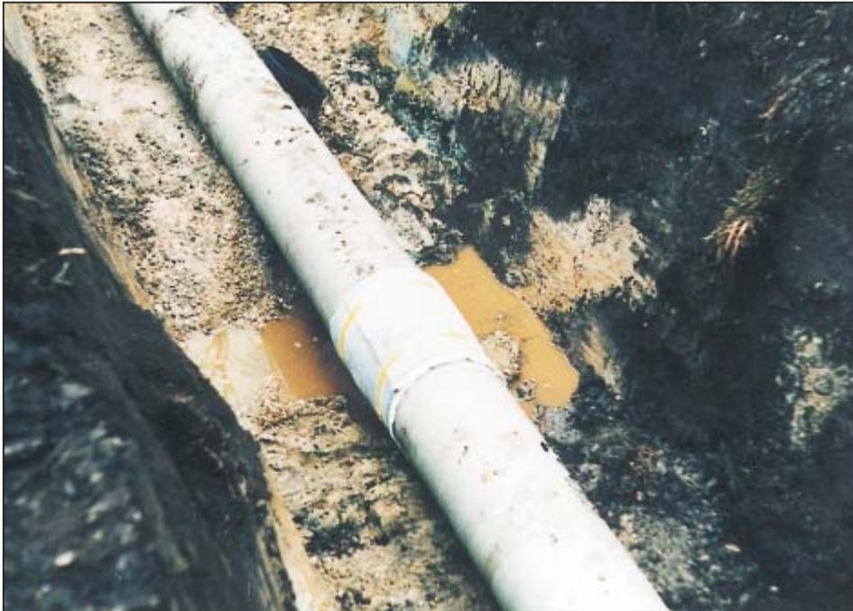
Um bei steinigen und felsigen Böden ein Durchdrücken von Steinen auszuschließen, kann zusätzlich eine Einbettung mit Sand von ca. 150 mm Dicke um die gesamte Felsschutzmatte erfolgen.
