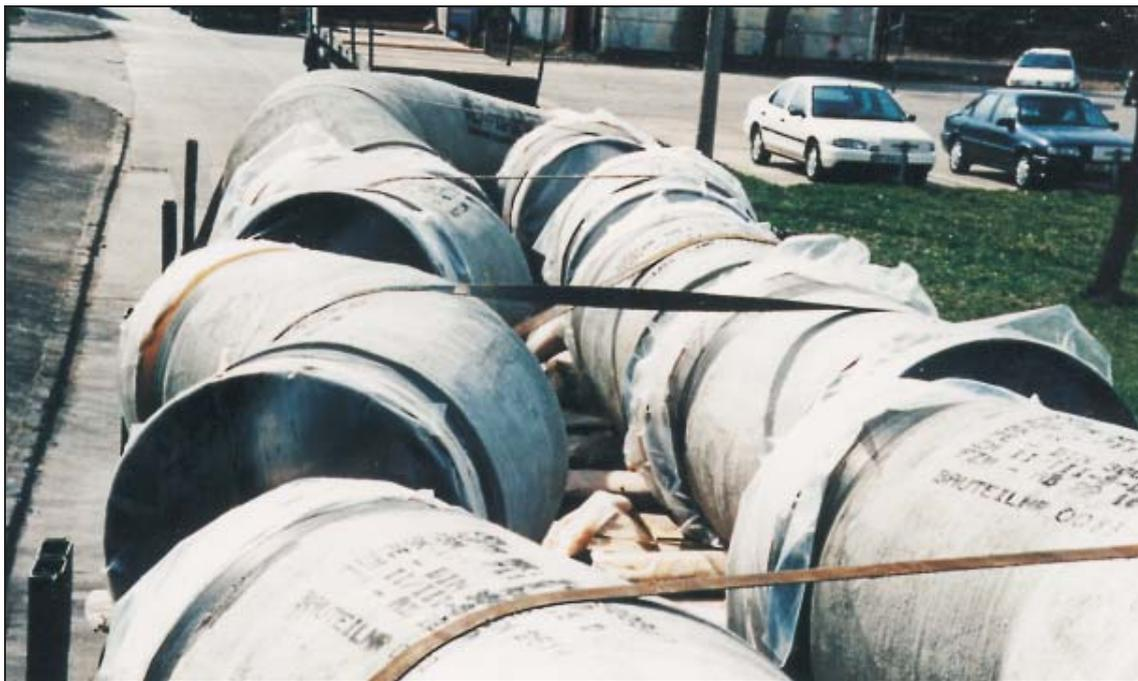
Unabhängig davon kann die Anfertigung von Formstücken auf der Baustelle notwendig sein. Für die Anfertigung solcher Formstücke werden ZM-ausgekleidete Stahlleitungsrohre (mit oder ohne äußeren Korrosionsschutz) entsprechend der gewünschten Formstückart getrennt, Ausschnitte angebracht und Stutzen bzw. Flansche angeschweißt. Bögen werden im allgemeinen aus Segmenten dieser Stahlleitungsrohre hergestellt, weil diese Rohre nicht kaltgebogen werden dürfen.
