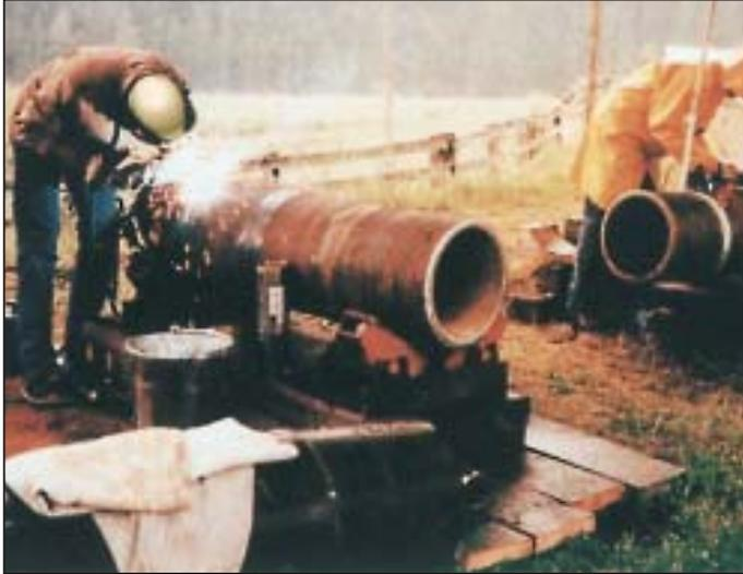
Das Anschweißen der Formstücke an die schon verlegten Stahlleitungsrohre erfolgt üblicherweise mit Stumpfschweißverbindungen (Bild 8.33).
