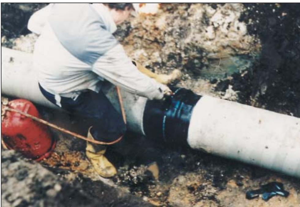
Die Nachumhüllung von Stumpf- und Einsteckschweißmuffen-Verbindungen erfolgt ebenfalls mit Schrumpfschläuchen oder mit montagefertigen Schrumpfmanschetten einschließlich Verschlusslaschen.
