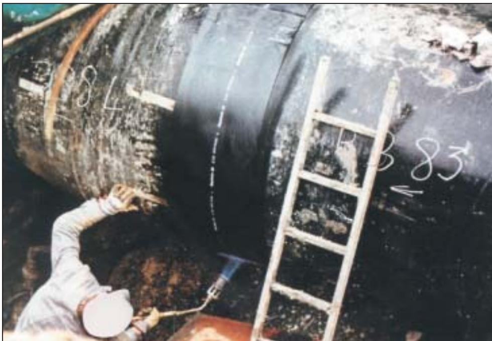
Alternativ kann die Nachumhüllung von Schweißnahtbereichen mit warm- oder kaltverarbeitbaren Korrosionsschutzbinden, die gleichfalls nach DIN 30672 genormt sind, vorgenommen werden.
